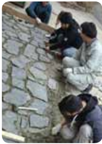
石巻・百俵館での石敷き作業
