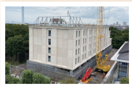
10月 医学部新講義棟は、2022年3月の竣工を目指して、建設が進んでいます
