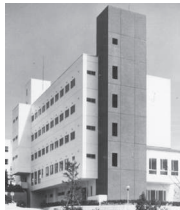
開設当時の保健学部棟
